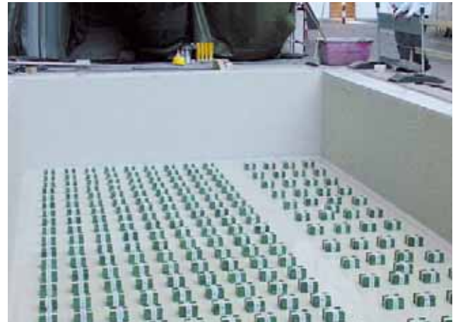
Mit Bilz Isolierplattensätzen ausgelegte Fundamentwanne
