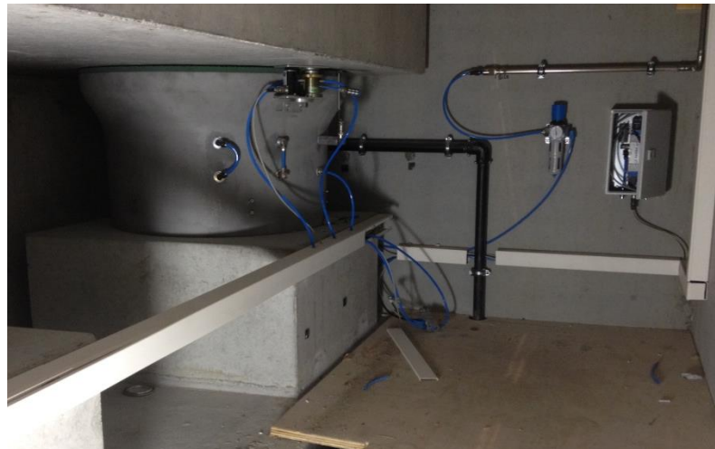
Abb. 4: Membran-Luftfedern BiAir® 5-ED/HE-Max unter dem Fundamentblock
